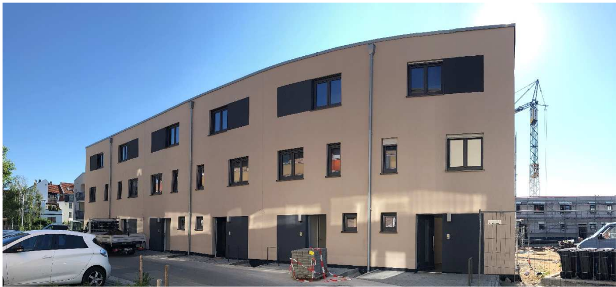
Im Ulanenpark werden aktuell die ersten Reihenhäuser bezogen, die die STADTBAU vermietet.
