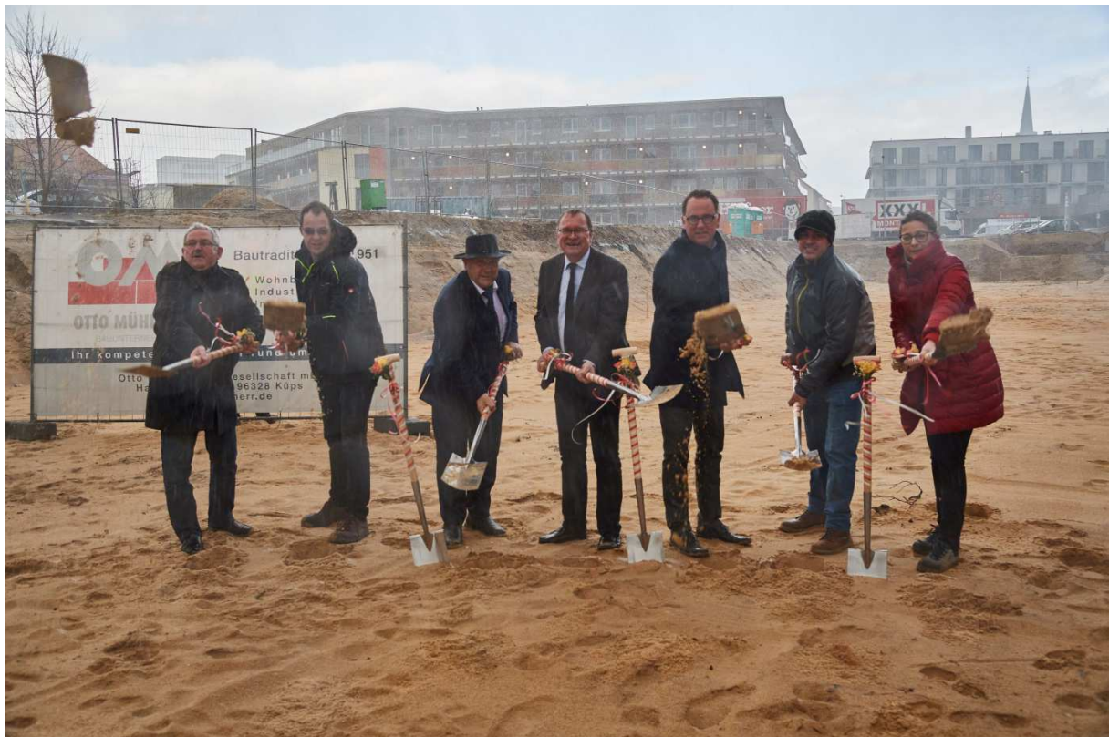
Die am Spatenstich Beteiligten ließen sich die Laune von einem Schlechtwetter-Schauer nicht verhageln. FOTONACHWEIS: Stadtarchiv / Jürgen Schraudner
